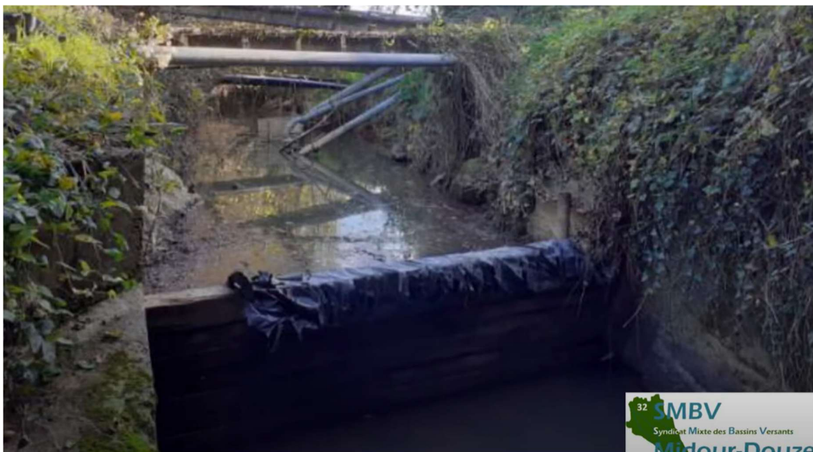
Exemple de travaux cité lors de l'atelier : la mise en place d'un puits en berge pour l'effacement d'un seuil de 80 cm et le regroupement de 5 points de pompage. Ci-dessus la situation initiale.
