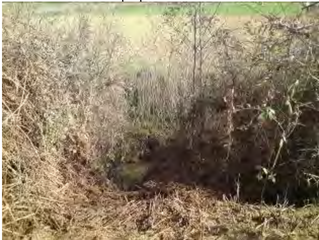
Avant travaux : rivière difficilement accessible, rejets étouffés
