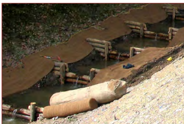
« Cascade » de seuils de fond en pieux et traverses
