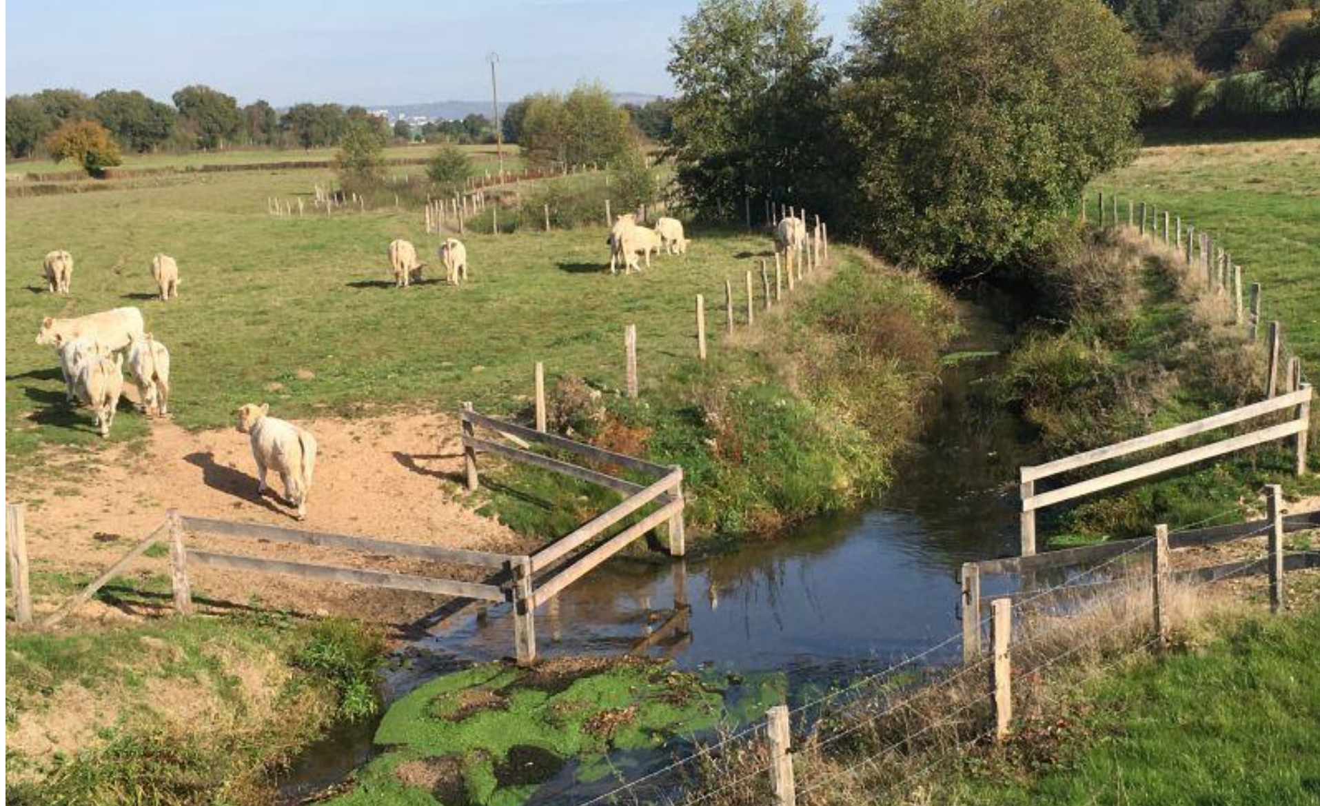
Exemple d'aménagement de rampe d'accès au cours d'eau pour bovin
