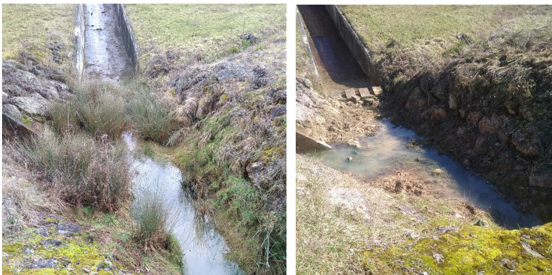
Figure 11 : Entretien ponctuel de la végétation dans le bassin de dissipation du barrage de Tillac
