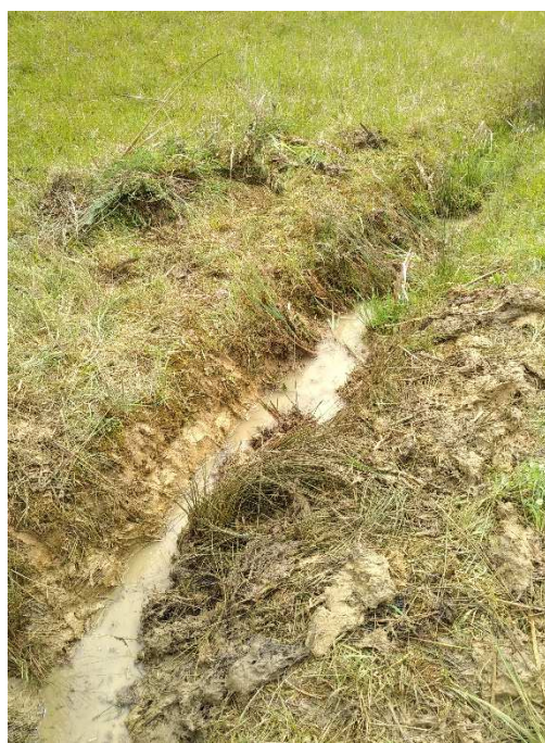
Figure 13 : Curage du pied rive droite du fossé du barrage de Tillac
