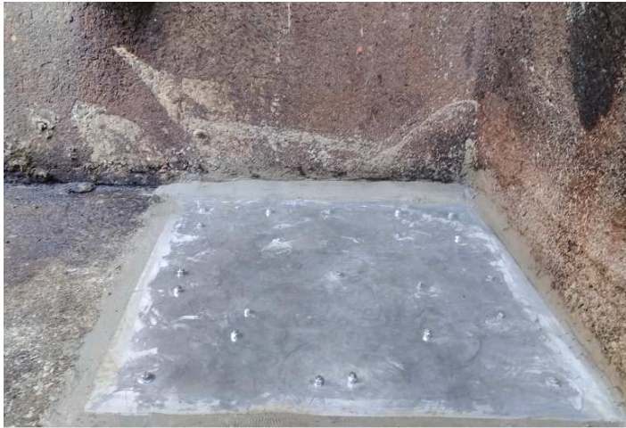
Figure 26 : Radier après réparation
