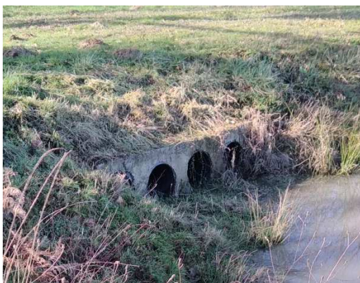
Figure 37 : Buses du barrage de Bougnères
