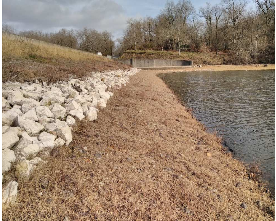
Figure 23 : Remontée des enrochements sur l'anti batillage en février
