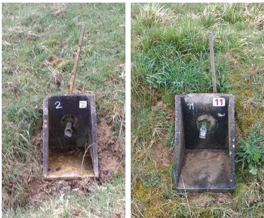
Figure 12 : Reprise des regards de drains et de leur numérotation pour le barrage de Tillac
