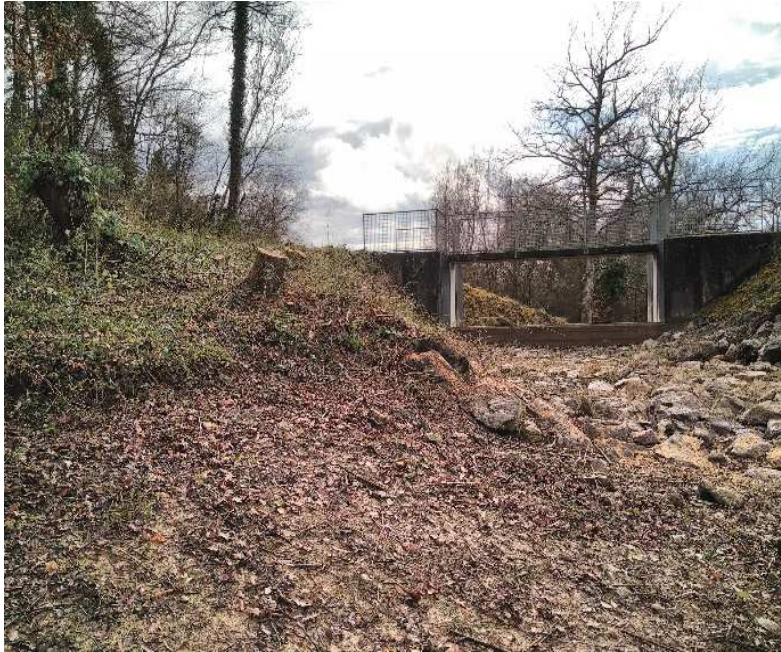
Figure 14 : Entretien de la végétation des enrochements en rive gauche amont du seuil de l'évacuateur de crues en mars
