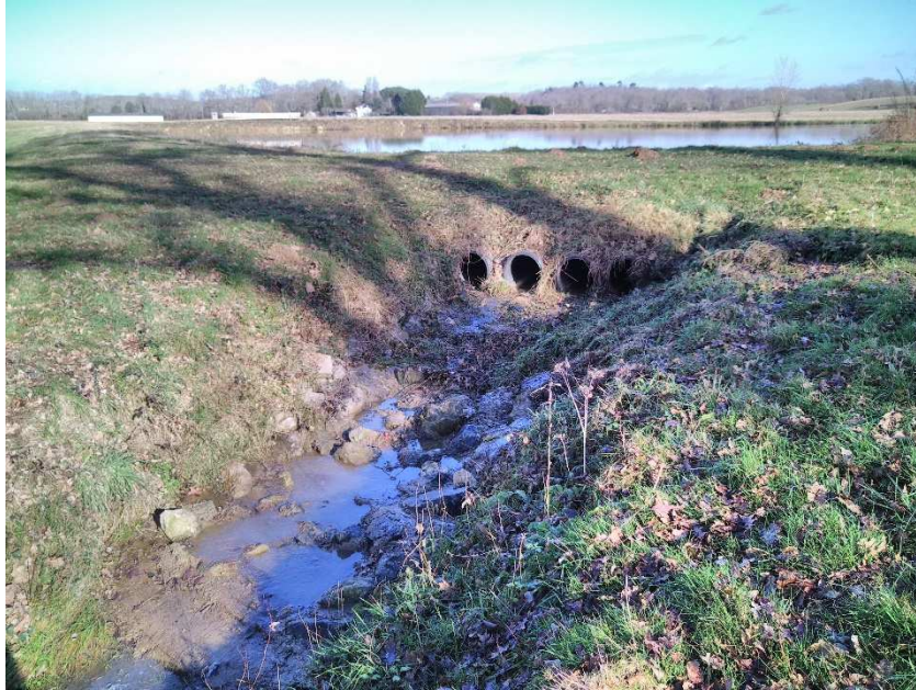
Figure 38 : Evacuateur de crues du barrage de Bougnères le 7 janvier 2022 après déversement du barrage
