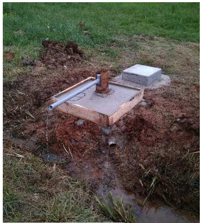
Figure 19 : Piézomètres après réparations
