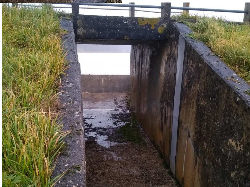
Figure 43 : Fissures en rive droite et rive gauche des bajoyers aval du dalot du barrage de Lapeyrie
