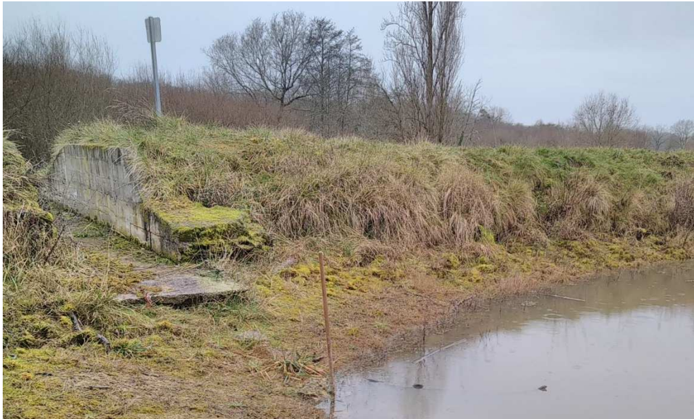
Figure 39 : Vue du parement amont et de l'érosion sous l'évacuateur de crues
