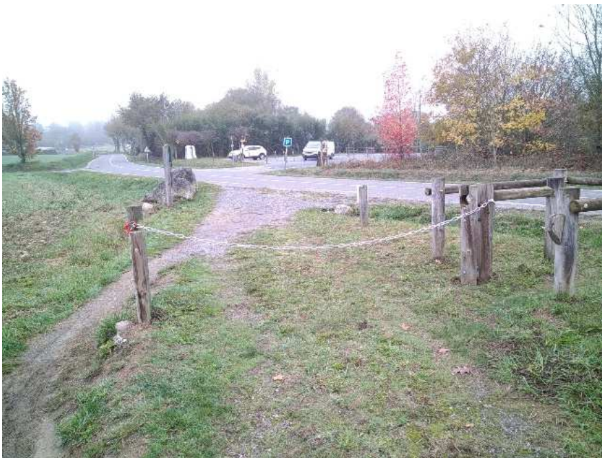
Figure 17 : Remplacement des barrières cassées avec remplacement par des chaînes.
