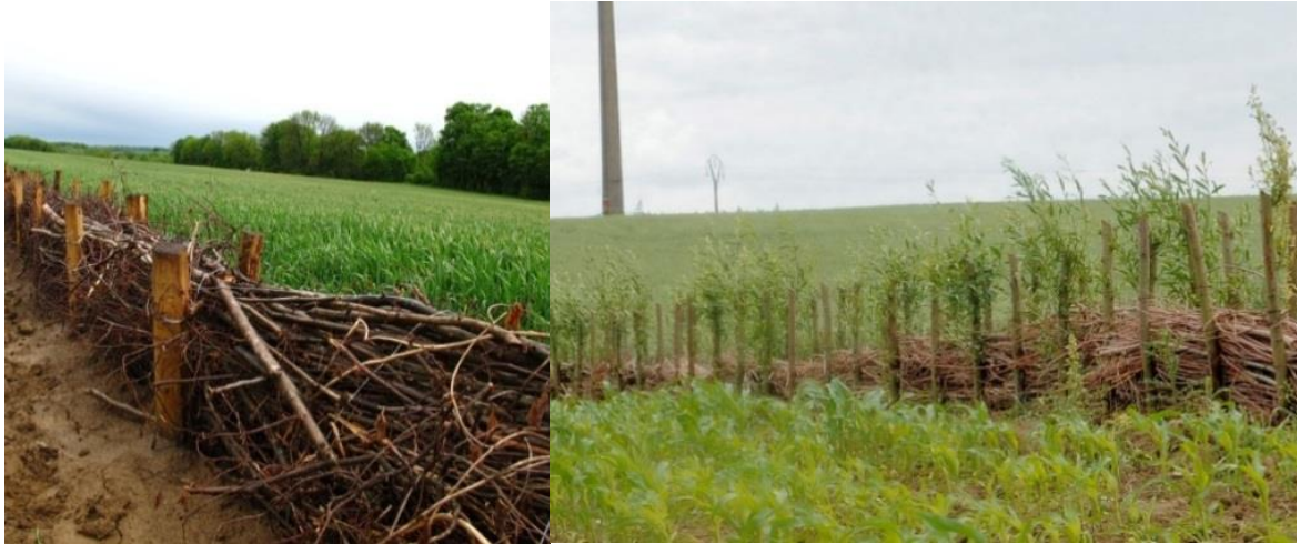
Figure 10 : Photos de fascines dites « mortes » à gauche et « vivantes » à droite Le positionnement des fascines et des haies peut être schématisé comme suit :
