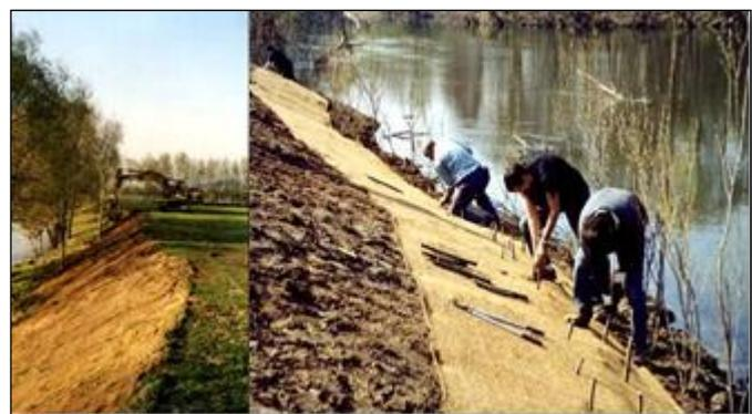
Figure 28 : Exemple d'intervention de talutage de berge
